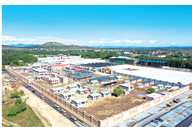
建设中的科右中旗国家中影视基地。
