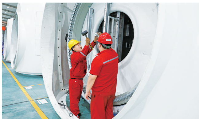
兴安盟经济技术开发区金风科技兴安盟风机总装及叶片厂项目。
