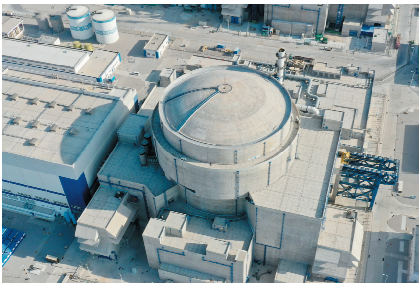
1月30日拍摄的 华龙一号 核电机组福建福清核电5号机组(无人机照片)。 新华社记者 林善传 摄
