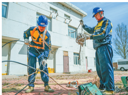
进行高压电缆头落地整治
