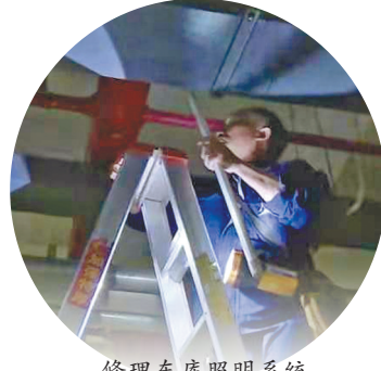
修理车库照明系统
