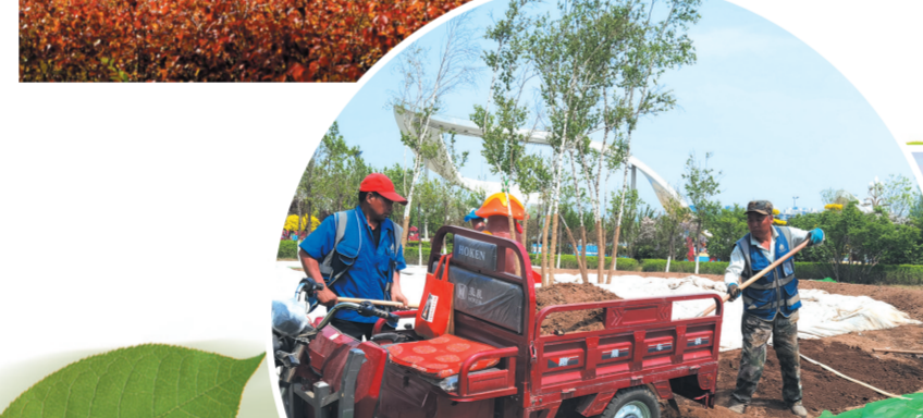
铺设游园小路。
