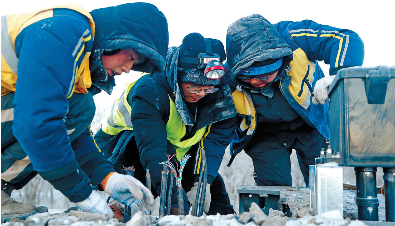
集二线电务设备改造工程完工
