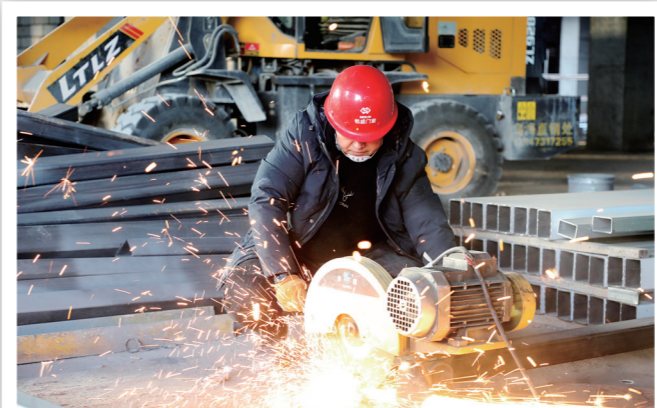
乌海摩尔城商业综合体项目室内装修施工中。 强建国 摄
