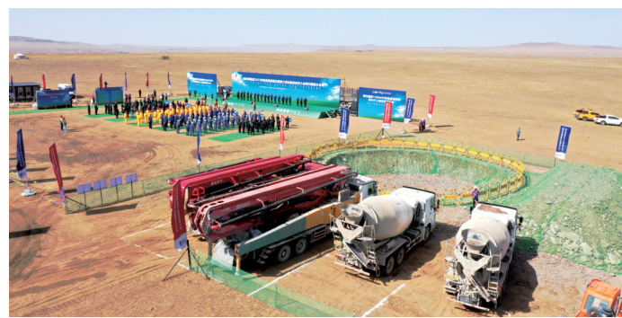
国家电投锡林郭勒盟阿巴嘎旗500MW风电基地项目顺利开工。
