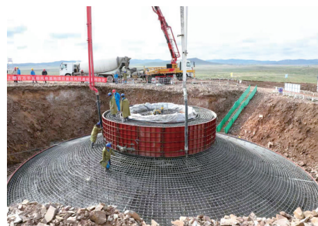
正旗旗北方之都百万千瓦级风电项目如火如荼建设中。
