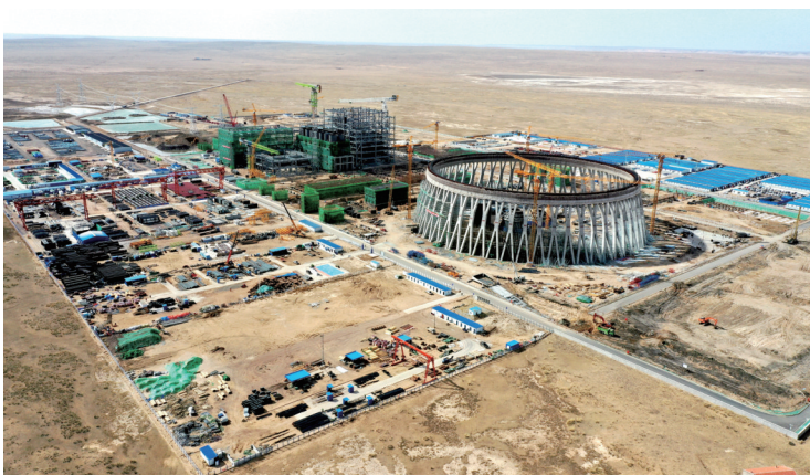
京能查干淖尔电厂2×66万千瓦项目现场。
