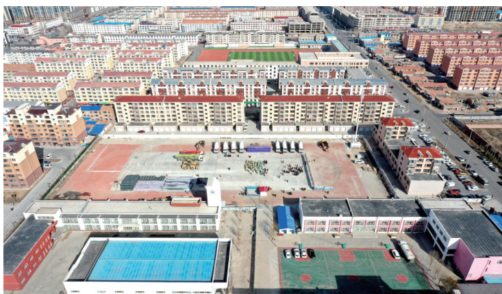
民生项目——锡林浩特市康兴幼儿园破土动工。
