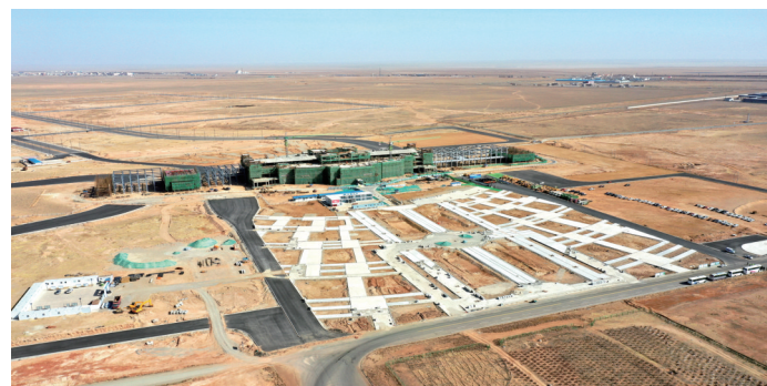
施工中的二连浩特-扎门乌德中蒙经济合作区查验区项目。
