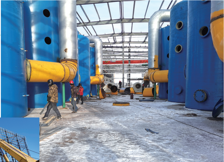
工人在开鲁县久鹏药业安装设备。吕志敏 摄
