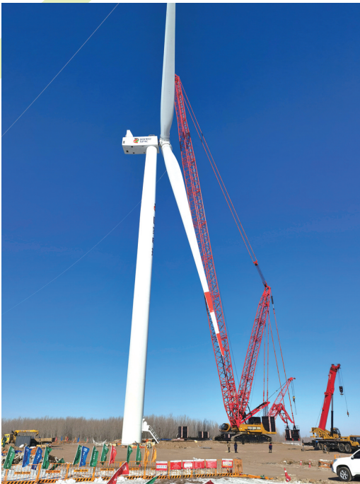
通辽百万风电外送项目(科左中旗珠日河50万千瓦风电项目)施工现场。萨如拉 摄
