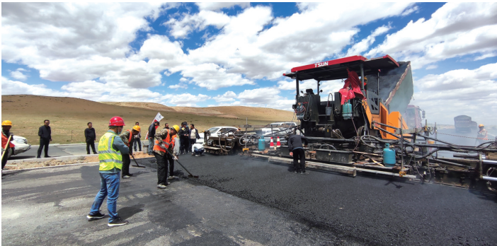
白安高速公路建设项目顺利完成胶粉改性沥青面层施工。
