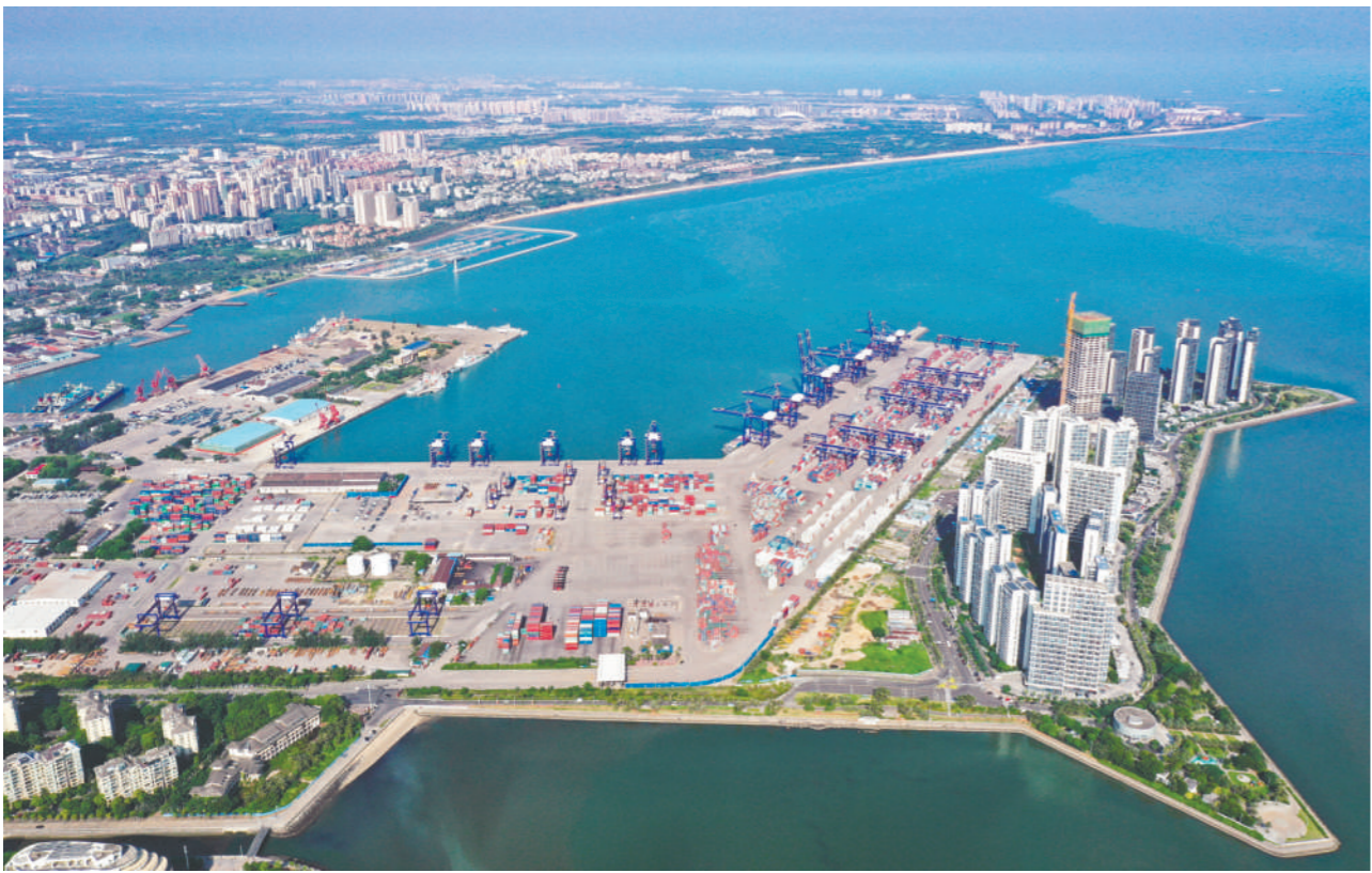
海南自贸港全岛封关运作首批项目集中开工
