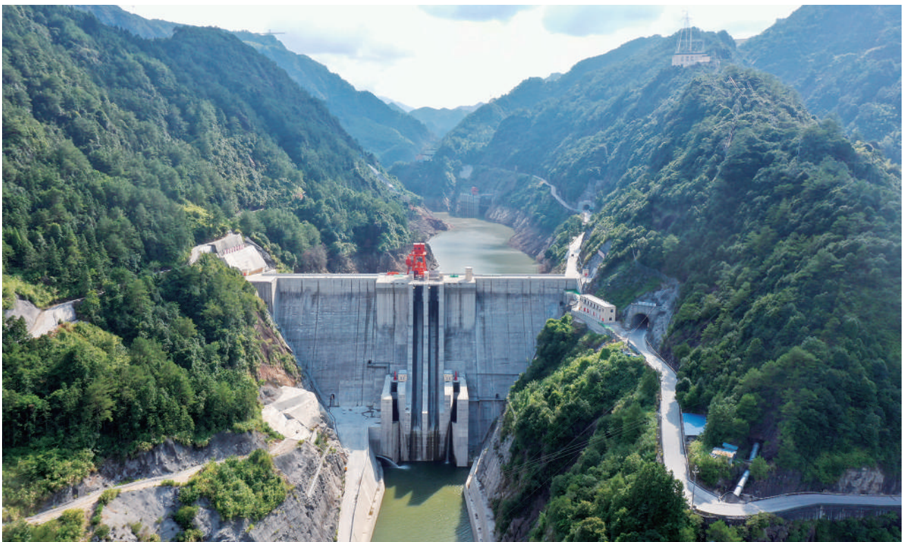
福建周宁抽水蓄能电站全容量投产
