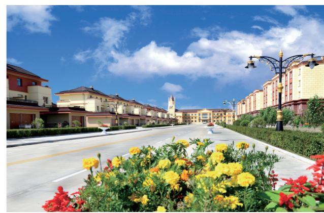
呼伦贝尔农垦谢尔塔拉农场公司打造的小城镇化建设样板。
