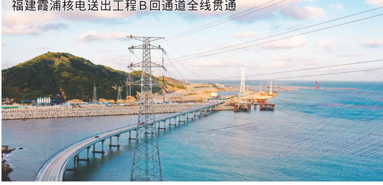
9月21日，宁德霞浦220千伏核电送出工程B回通道全线贯通（无人机照片）。9月21日，位于福建宁德霞浦的220千伏核电送出工程B回通道计划于今年11月全线贯通。该工程是中核霞浦核电重要送出线路，全长48.983千米，新建铁塔133座，其中跨海段长4.39千米。工程投产后，将进一步解决闽东电源供应问题，加速推进福建省沿海核电建设，助力完善新能源供给消纳体系。
