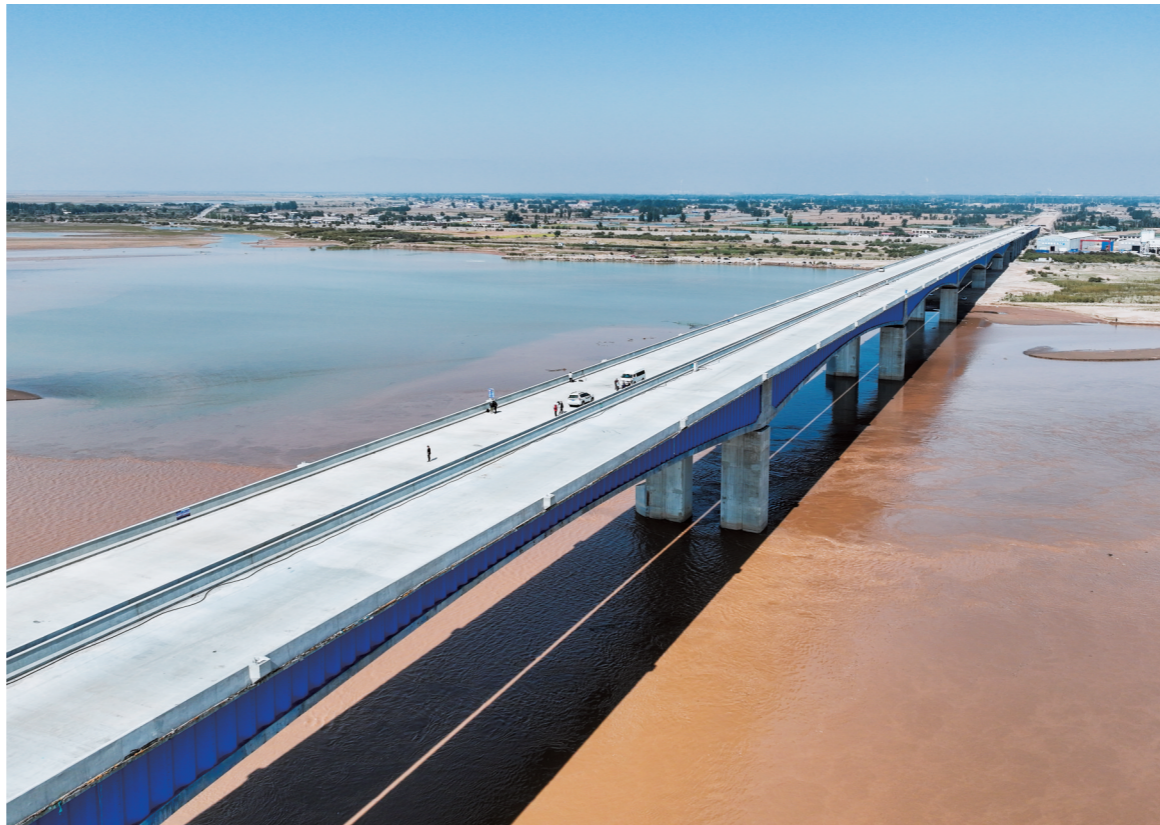
昭君黄河特大桥主体完工
