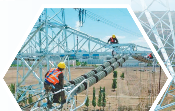
包银高铁首条500千伏超高压电力线路改造工程。通讯员 陈旭 摄
