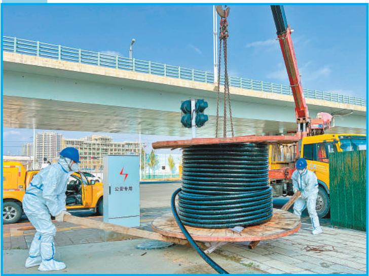
呼和浩特供电局工作人员全力施工,保障信达国贸方舱医院电力供应。 本报记者 王晓博 通讯员 李顺鹏 摄
