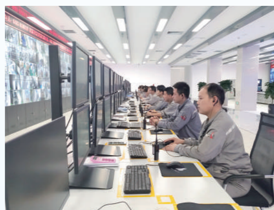
内蒙古圣作物科技有限公司中控室工作人员聚精会神保障各生产车间数据稳定。
