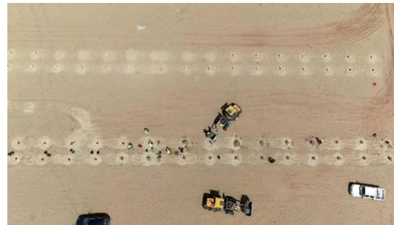
施工中的项目基地。
