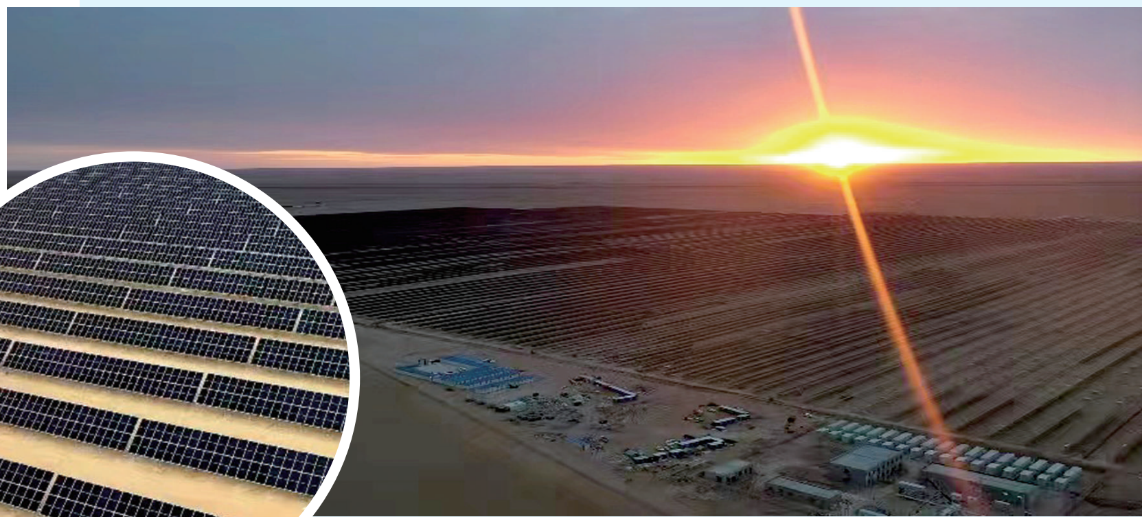
夕阳下的光伏电站。
