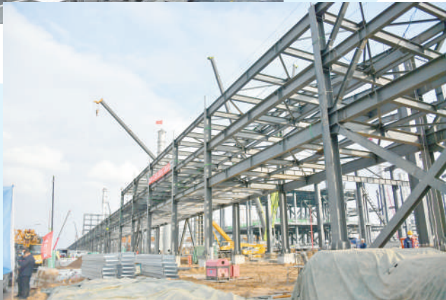
内蒙古大全新能源有限公司年产10万吨高纯多晶硅基材料和1000吨半导体硅基材料项目建设中。
