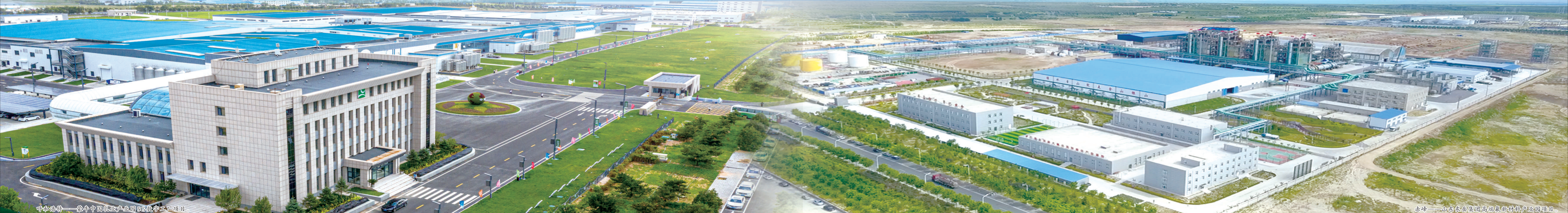
呼和浩特——中环新能源产业园3期续建工程二期项目。
