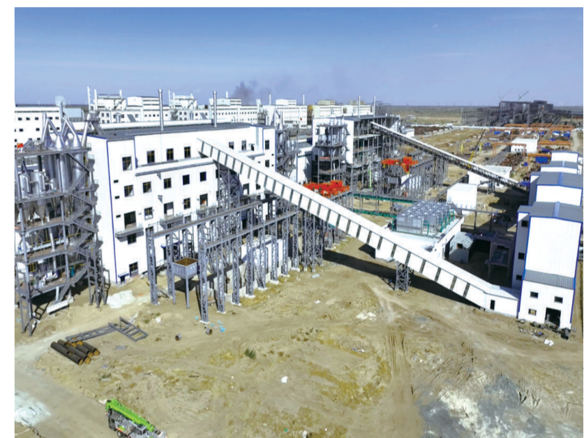
通辽——河北华实实业集团有限公司不锈钢轧钢酸洗建设项目。
