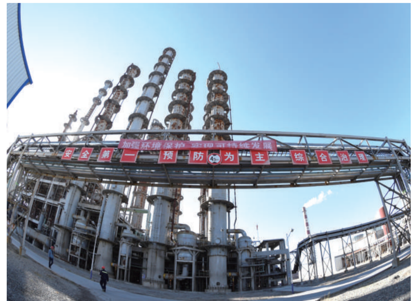
巴彦淖尔——东立光伏年产4.8万吨高纯晶硅及7500MW太阳能电池组件光伏产业链项目。
