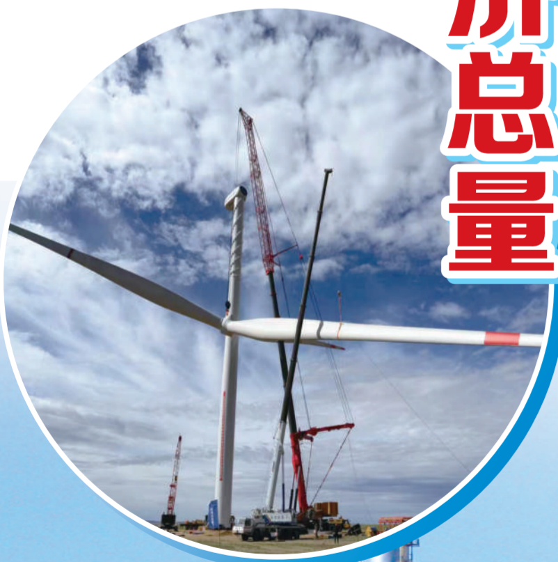
锡林郭勒盟——苏尼特左旗蒙能特高压外送电项目。
