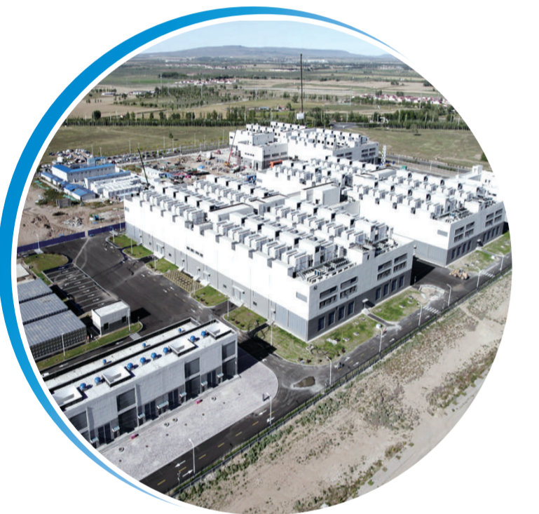
乌兰察布——北京快手科技有限公司投资的数据中心项目。
