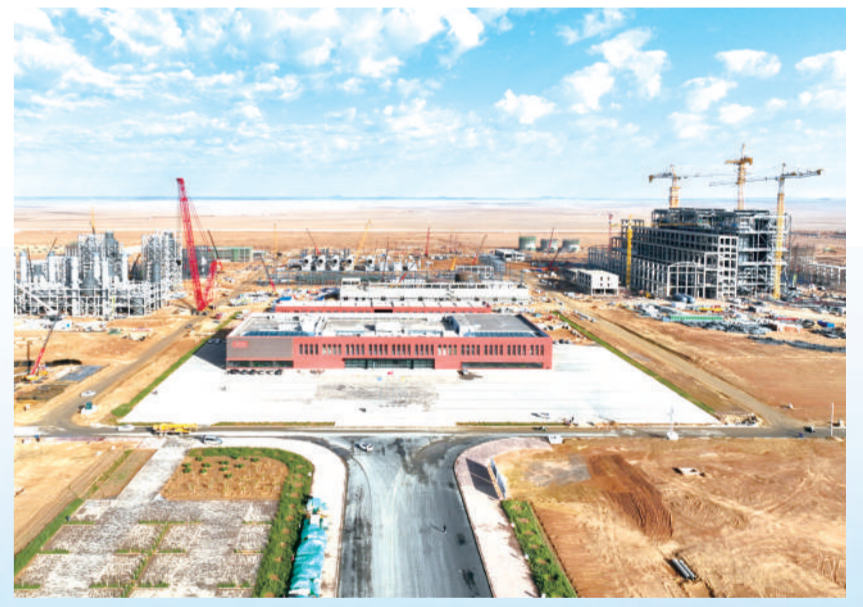
阿拉善——博源阿拉善塔木素天然碱开发利用项目。
