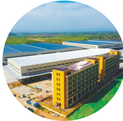
上海韵达货运有限公司内蒙古快递电商总部基地项目
