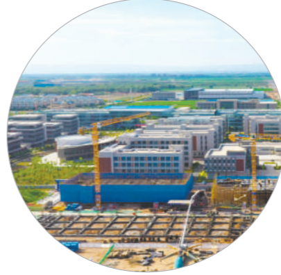
和林格尔新区智能制造产业园二期项目
