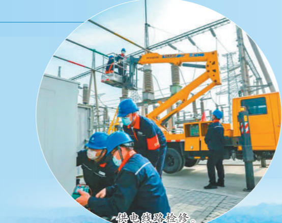
供电线路检修。
