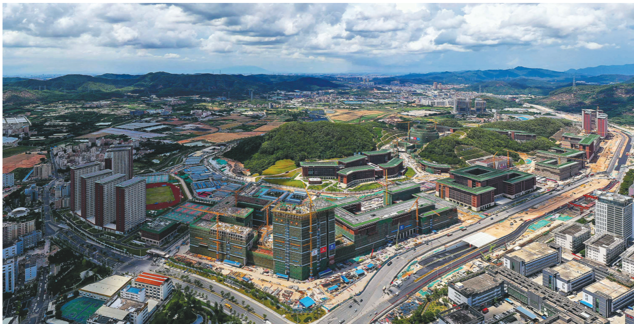
这是2021年5月26日拍摄的中山大学深圳校区“中大城”已经启用的一期西园和二期建设现场(无人机照片)。广深科技創新走廊“中大城”是集科研、创新、生态于一体的区域教育高地、医疗高地和创新高地,以生物医药产业、新一代信息技术产业和先进制造业为主导产业。
