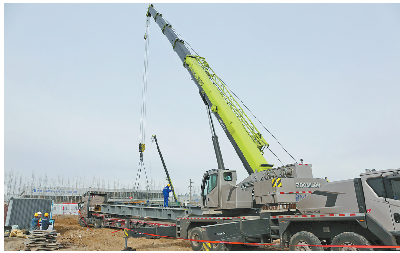
大型起重机吊装钢结构材料。
