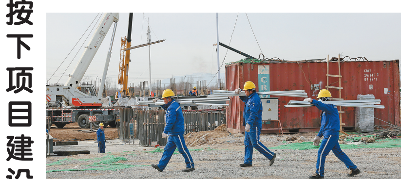
工人正在搬运施工材料。
