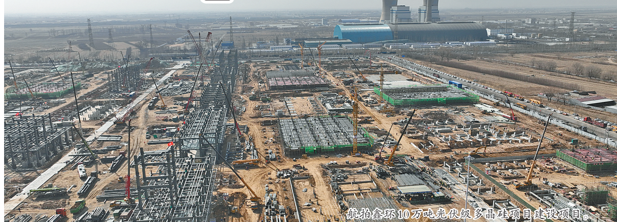
航拍鑫环10万吨光伏级多晶硅项目建设现场。
