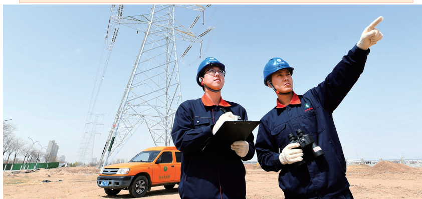
4月18日,在包头稀土高新区500千伏特高压改迁后的新址,电力工作人员正在进行线路巡视。 本报记者 金泉 摄
