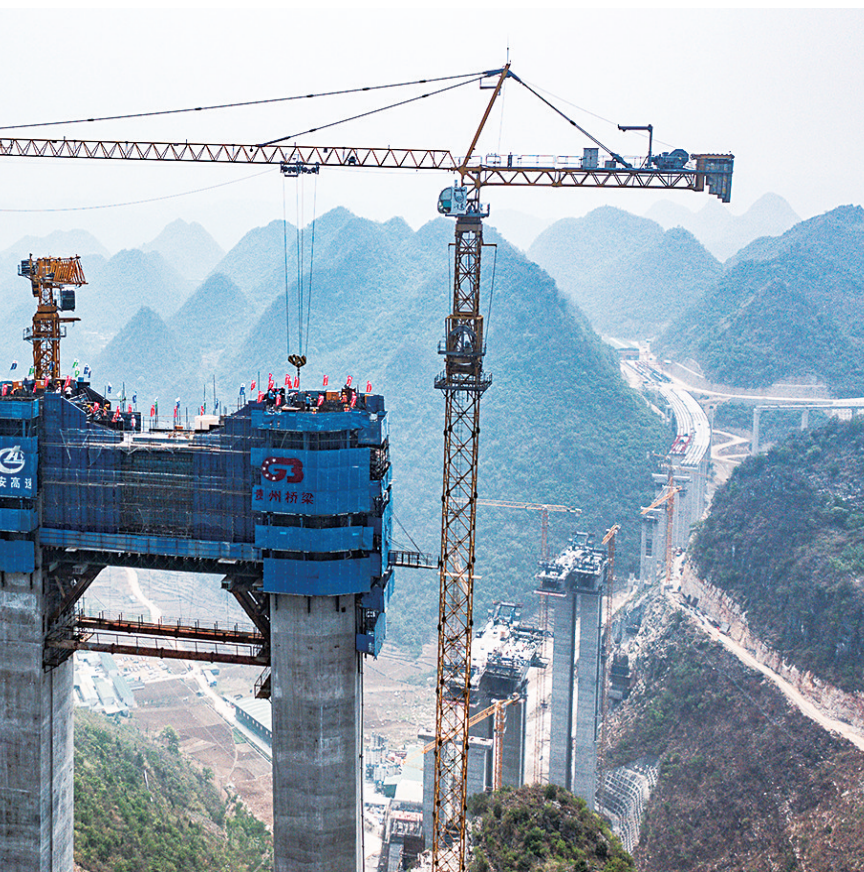
花江峡谷大桥6号主塔顺利封顶
