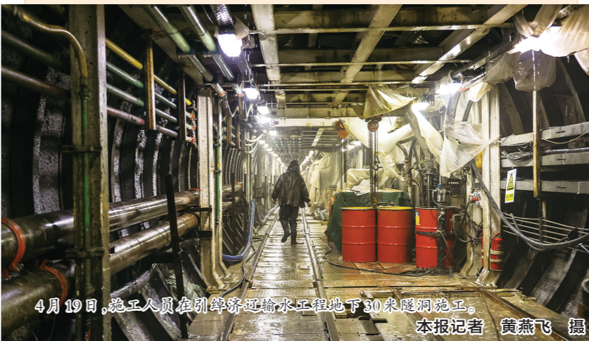
4月19日,施工人员在锦济辽输水工程地下30米隧洞施工。 本报记者 黄燕飞 摄
