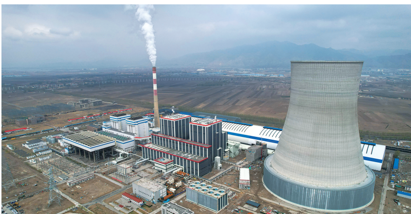
正在运行中的金山热电二期2×66万千瓦扩建项目。
