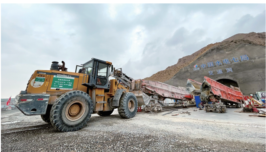
乌海抽水蓄能电站施工现场。
