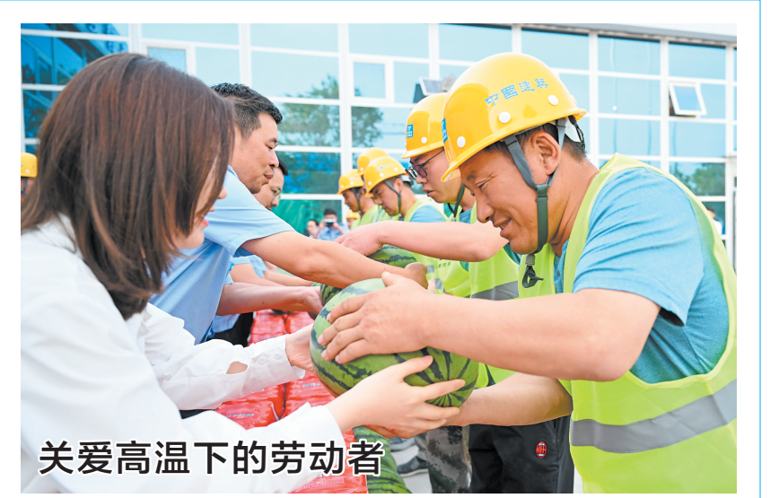
关爱高温下的劳动者 6月16日,在天津市滨海新区耀华中学校项目工地,中建二局四公司工作人员为一线工人送去西瓜。近期,全国多地陆续迎来高温天气,各地采取相关措施,做好防暑降温,确保高温户外劳动者的安全。 新华社记者 赵子硕 摄
