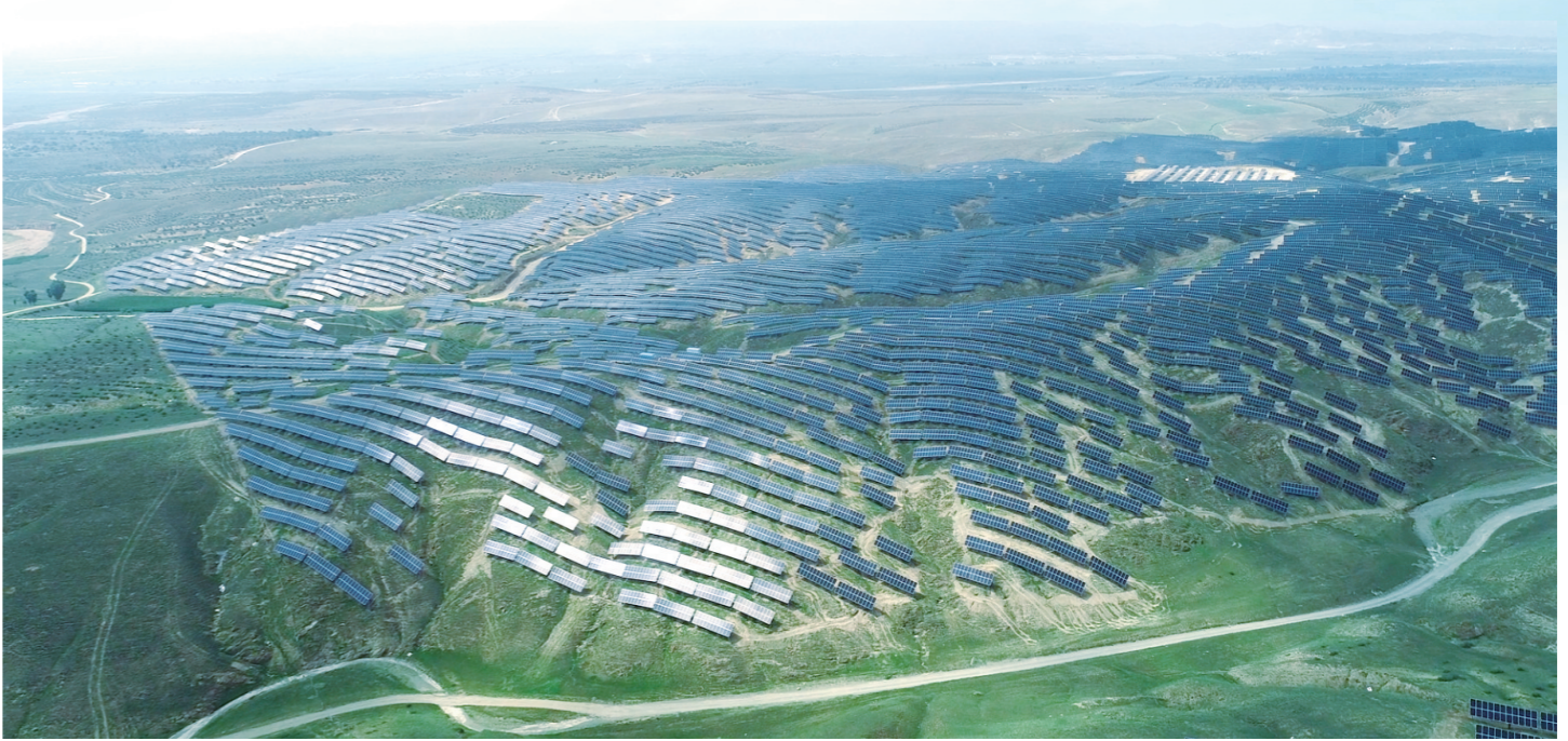
蒙能集团建设的光伏电站。
