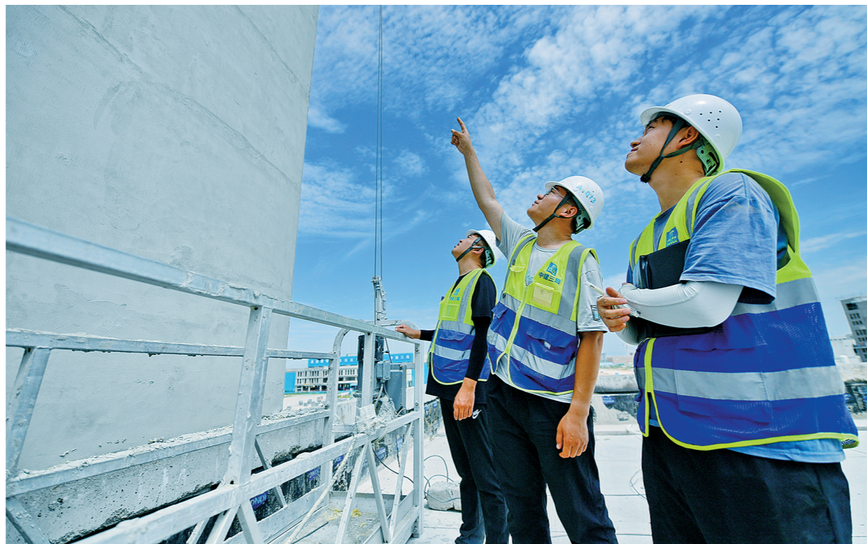
对外墙保温层开展施工质量验收。
