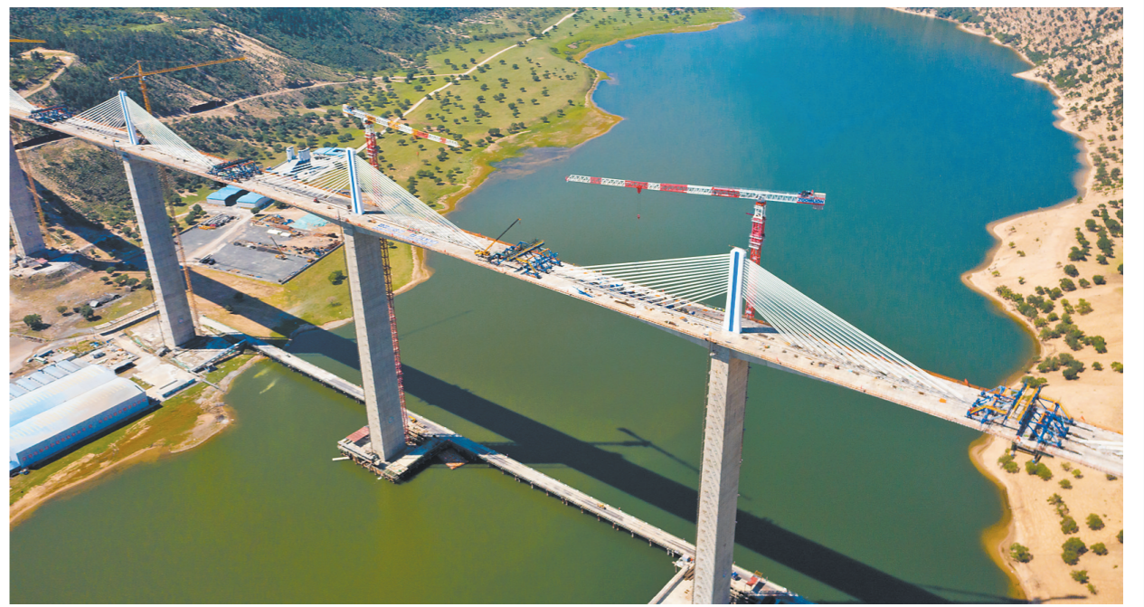
西拉沐沦特大桥合龙
