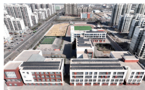
海勃湾区屋顶分布式光伏项目。
