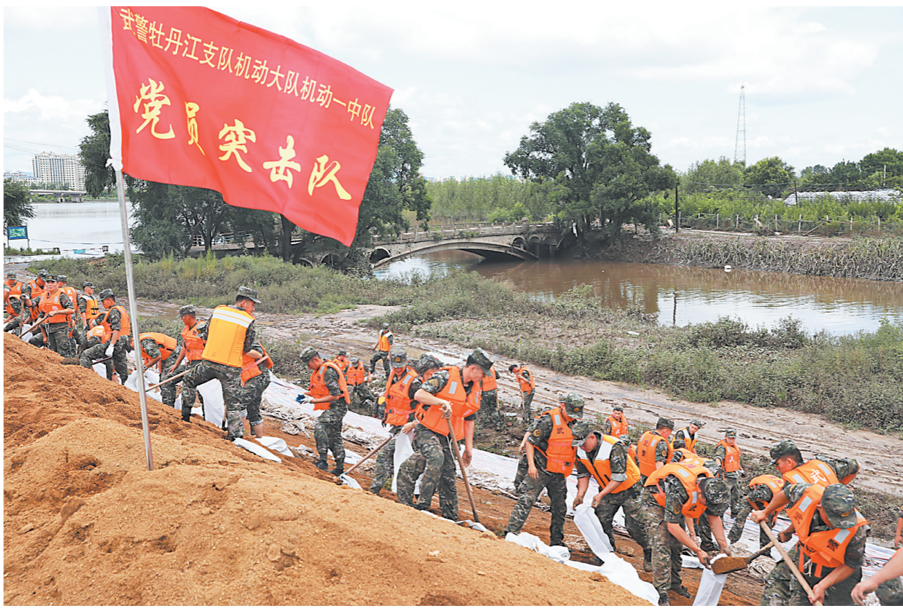
武警黑龙江总队牡丹江支队组织党员突击队对东安区东小河水堤进行加固(8月9日摄)。
