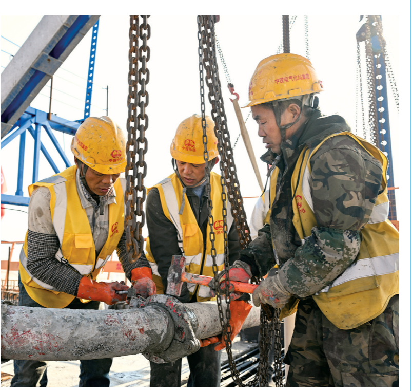
集通铁路电气化改造工程 最大跨度刚构连续梁合龙
