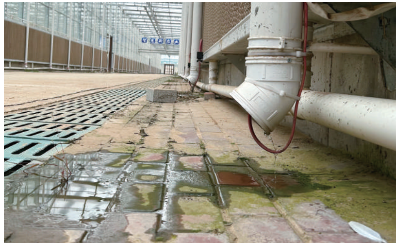
雨水在温室棚顶被收集后顺着管道流进水沟。
