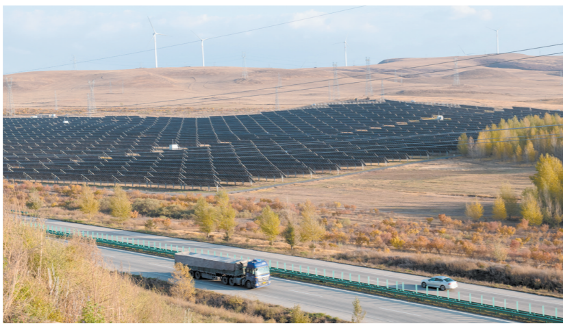
霍林郭勒市的光伏产业。
