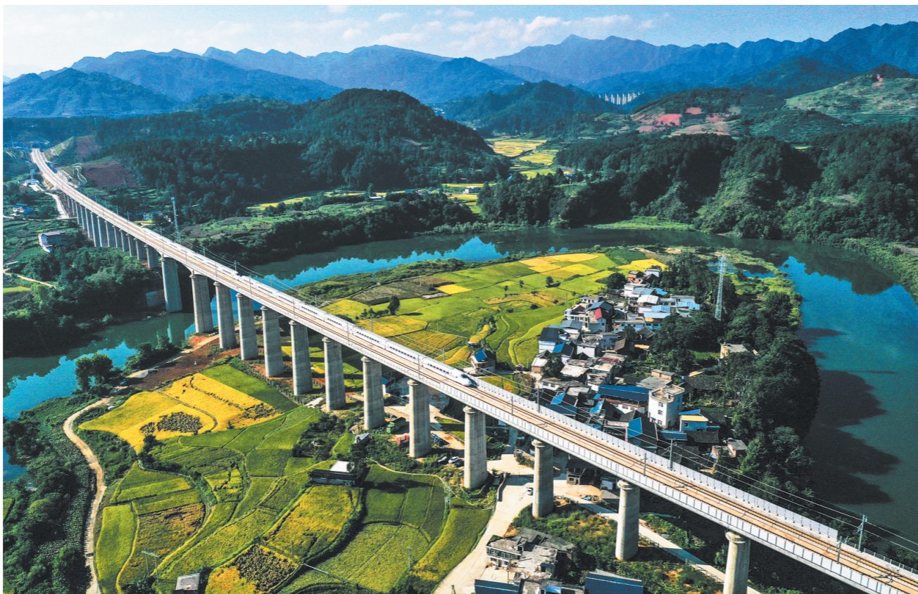
2023年8月31日,一列动车组列车经过位于贵州省都匀市境内的贵南高铁盘清水河双线特大桥(无人机照片)。
