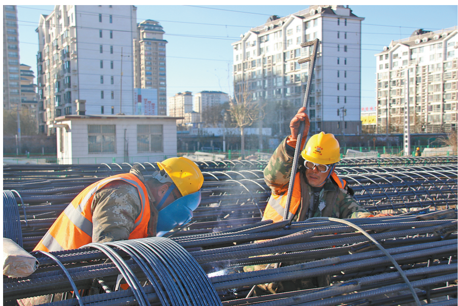
由中铁二十局承建的包银高铁乌海段项目没有因寒冷而停歇,工人们正在加紧施工。 本报记者 郝随 摄
