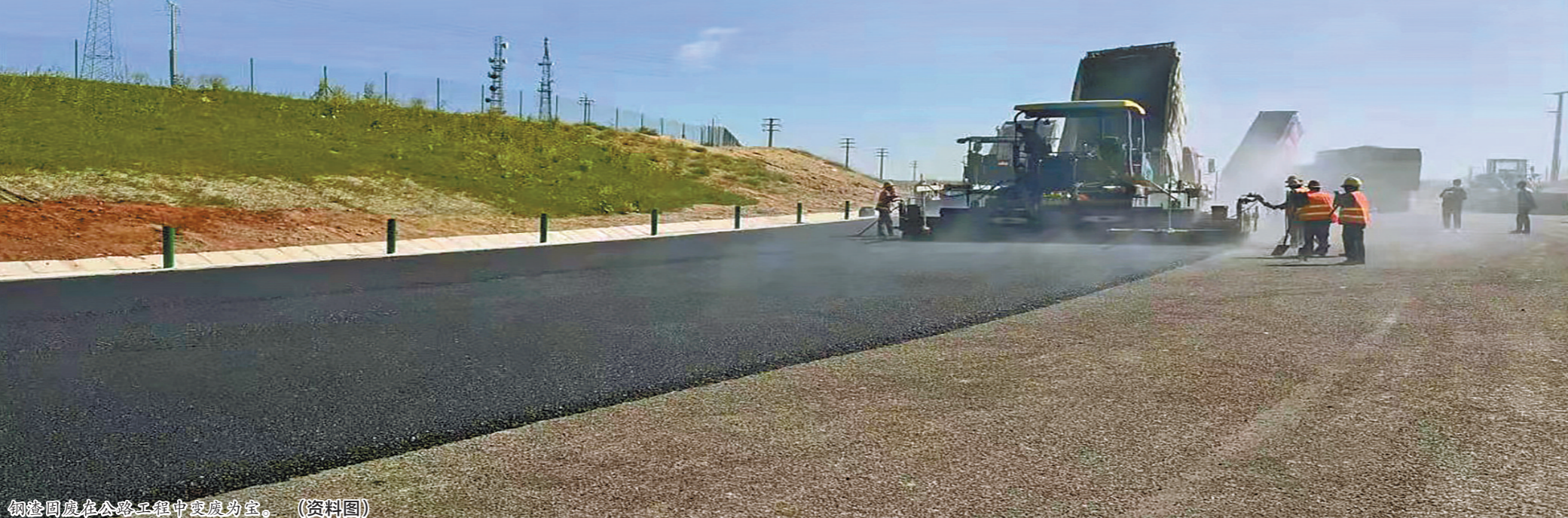
钢渣固废在公路工程中变废为宝。(资料图)
