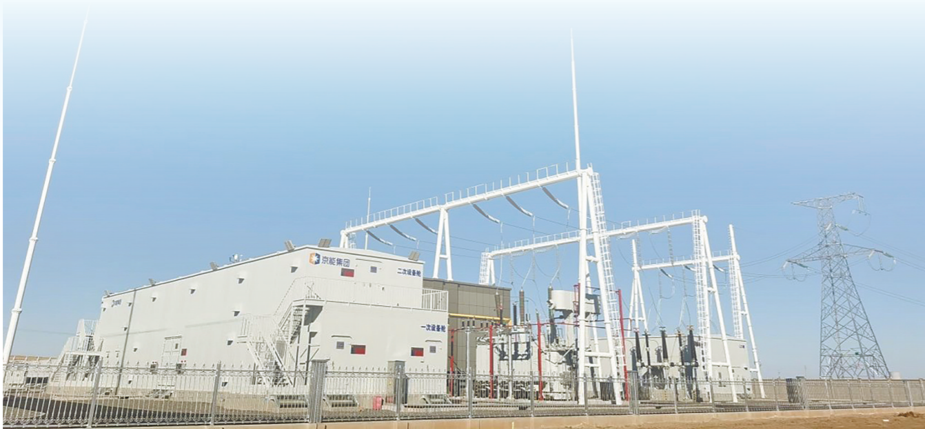
11月21日，京能查干淖尔电厂风光火储氢示范项目阿巴嘎旗30万千瓦风电项目首台风机正式并网发电。
