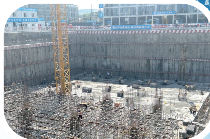
京蒙(亦庄·赤峰)科创产业园在北京加紧建设。
