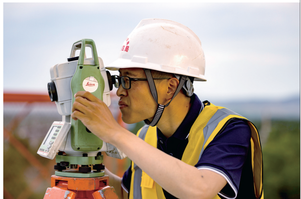
集大原高铁施工作业现场。曹亮 摄
