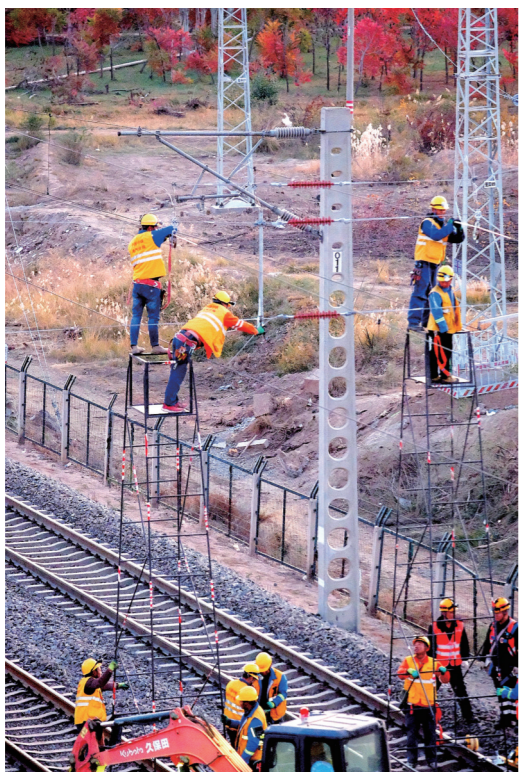
临河站改造施工现场。赵文刚 摄
