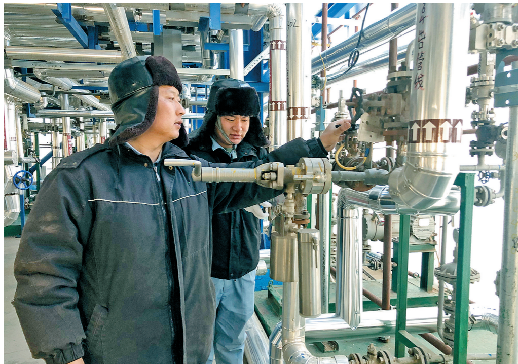
科研人员进行 \alpha -烯烃中试生产工艺调整。
