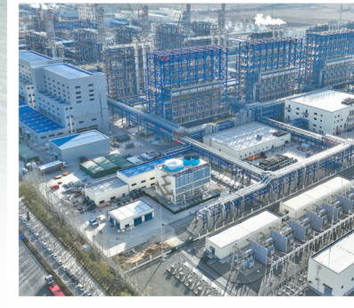
10万吨颗粒硅项目航拍图。
