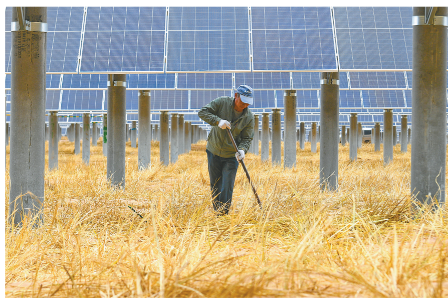
在内蒙古能源集团磴口县85万千瓦“光伏+生态治理”项目区,工人正在进行压制草方格作业,为下一步在草方格内栽植灌木苗做准备。 本报记者 孟和朝鲁 摄
