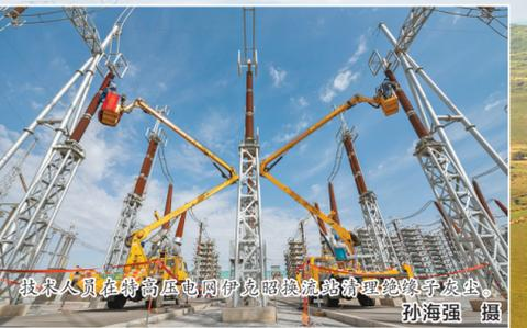
技术人员在特高压电网伊昭换流站清理绝缘子灰尘。孙海强 摄
